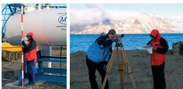
Rysunek 11. Pomiar wysokości reperów na stopach fundamentowych zbiorników paliwowych (fot. Z. Malinowski)
